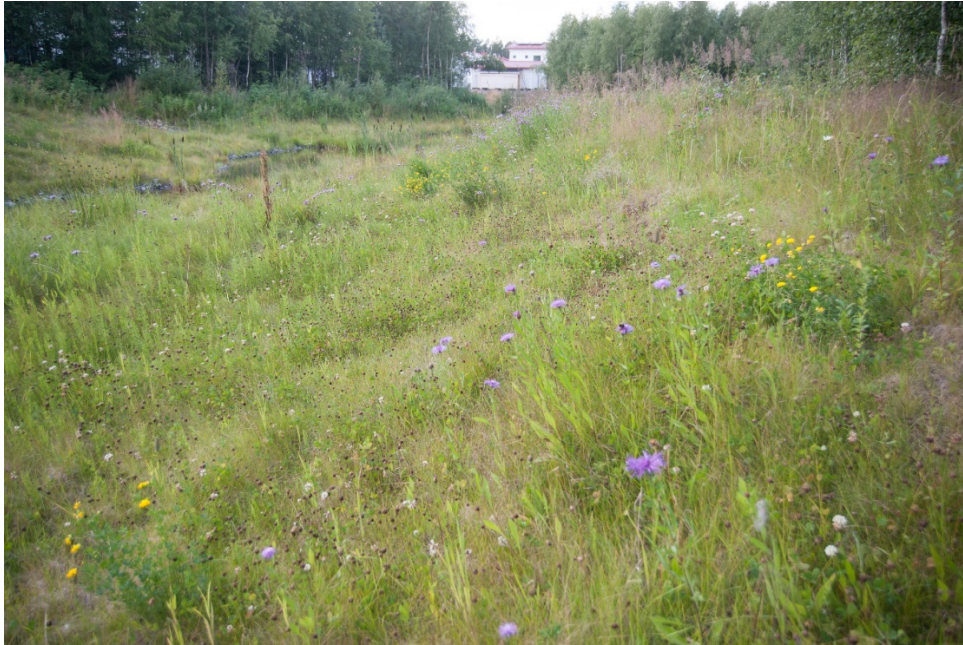
Kuva 47. Hulevesipainanteen luonnemalli. Tässä mallissa on pysyvä vedenpinta vain pohjassa tai ei lainkaan.
