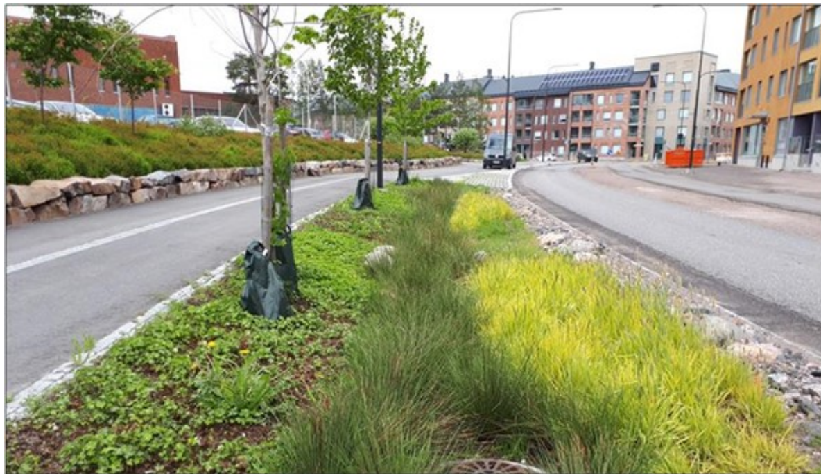
Kuva 42. Erotuskaista toimii samalla hulevesipainanteena.
